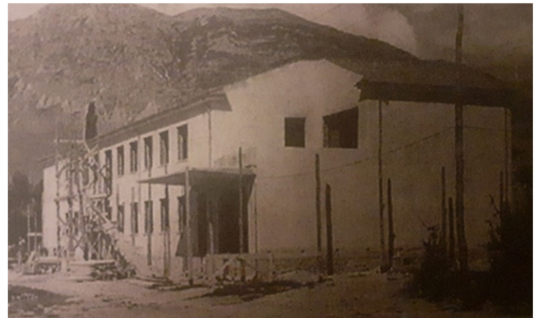
Cantiere costruzione scuola
